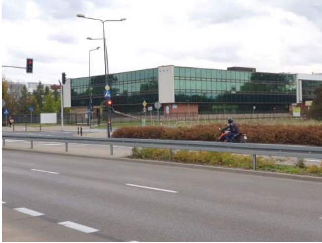
fot.1,2. Budynek Biblioteki od strony dojazdu z centrum Warszawy ul. Nowoursynowską
